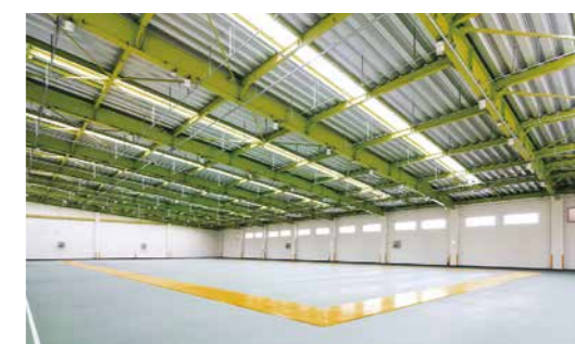
▲土間免震某倉庫
