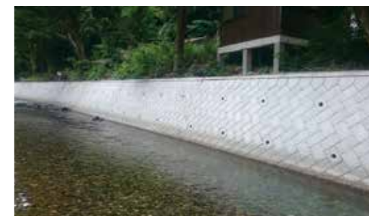
▲施工事例(和歌山県九度山町)
