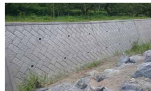
▲施工事例(和歌山県九度山町)
