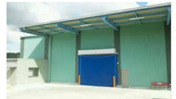
▲第二工場外観
