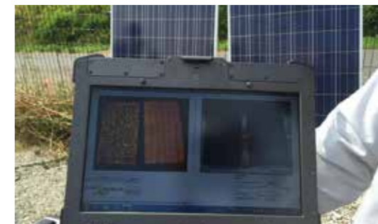
▲EL検査で不良箇所が見える化
